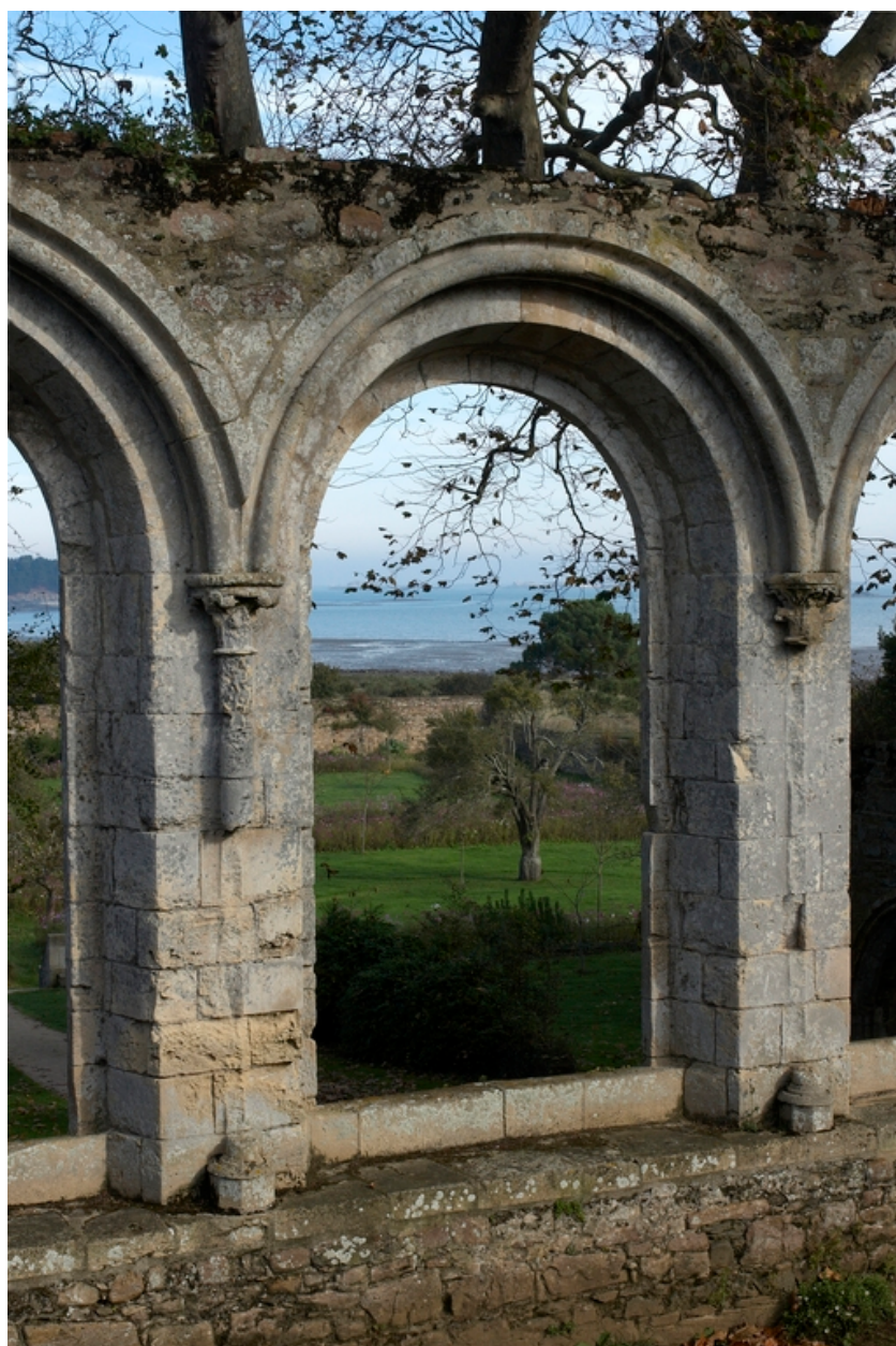
Mur nord du réfectoire, détail du fenestrage
