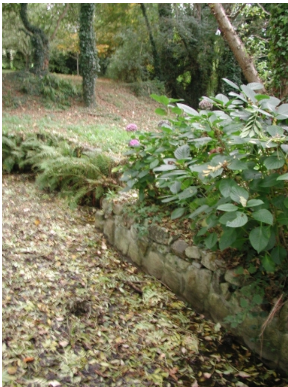
Vue des murets du routoir
