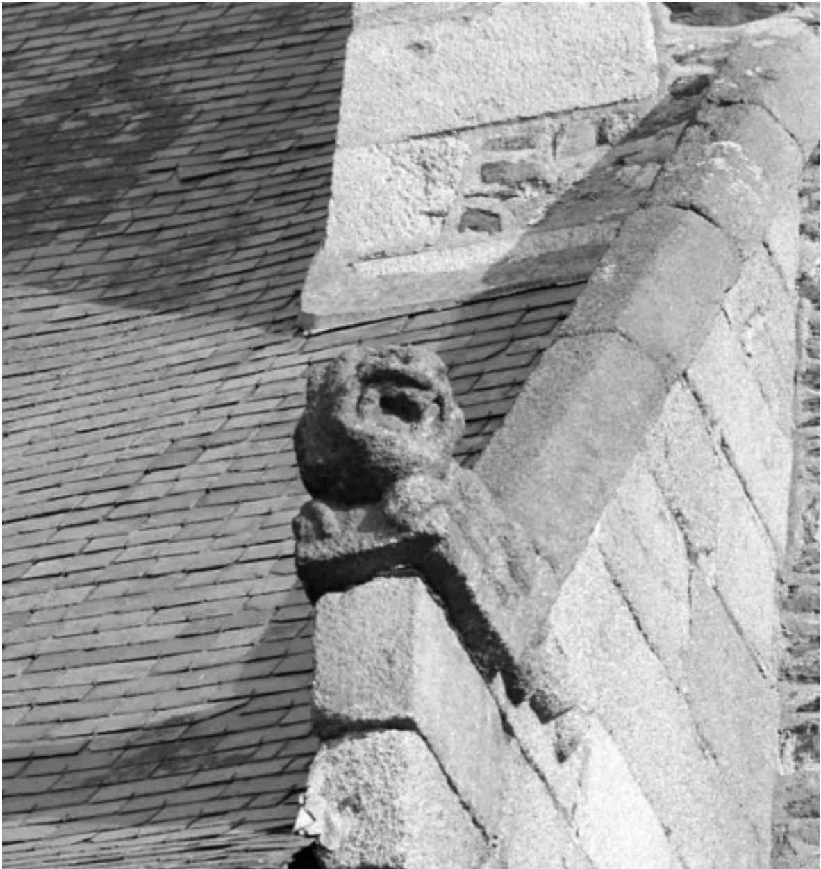
Détail sur une crossette
