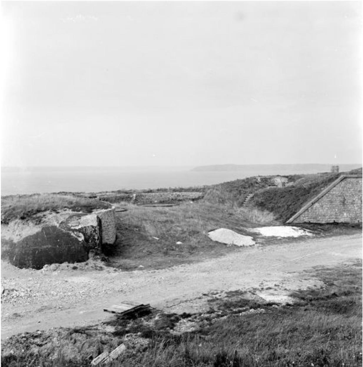
Vue de la batterie du Toulinguet en 1969 : batterie de 24 cm, position de droite. A gauche : magasin de batterie en béton, à droite : traverse-abri en maçonnerie
