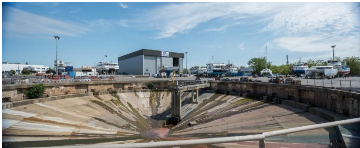
Vue générale de la fosse du slipway vers le nord
