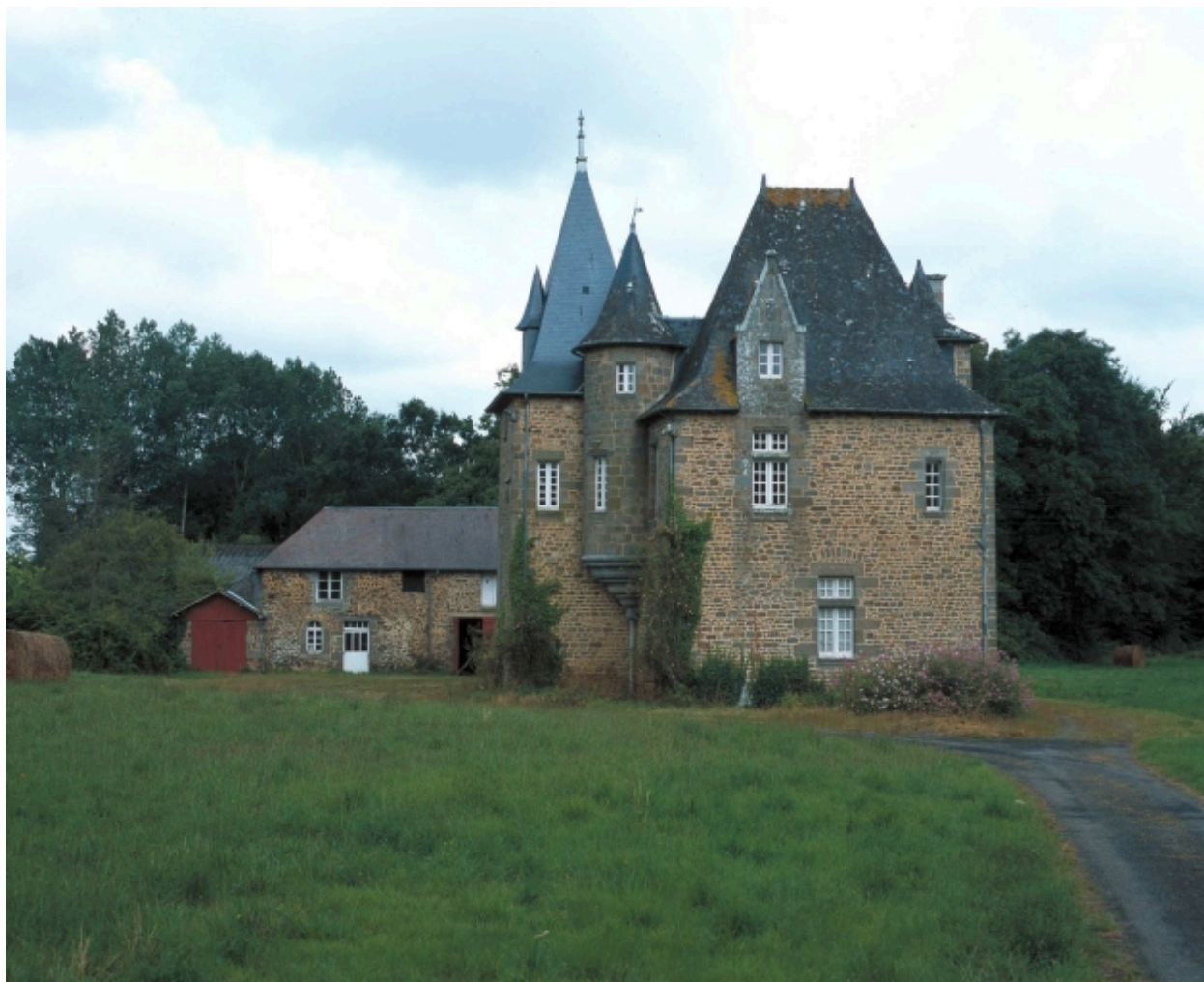
Vue générale est
