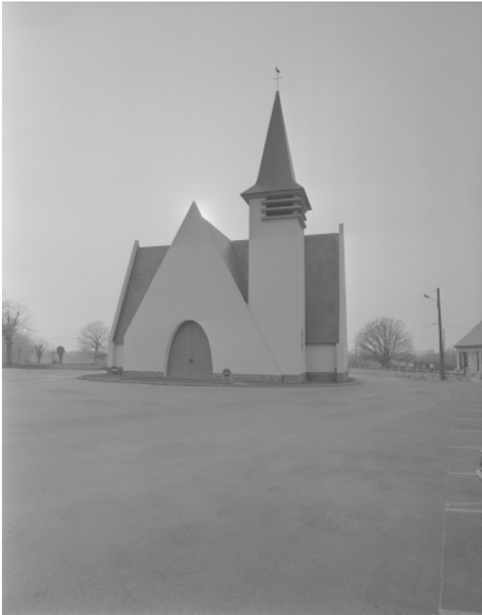
Elévation Sud : vue générale
