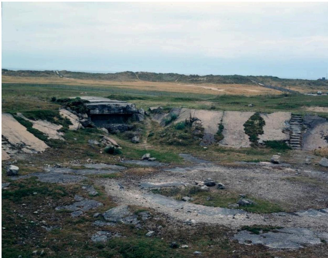
Vue du bunker - cuve pour canon de 34 cm avec magasins de munitions nord (état en 1994). L'abri en béton armé visible sur la photographie était destiné à protéger la partie avant du wagon permettant le transport de la pièce d'artillerie
