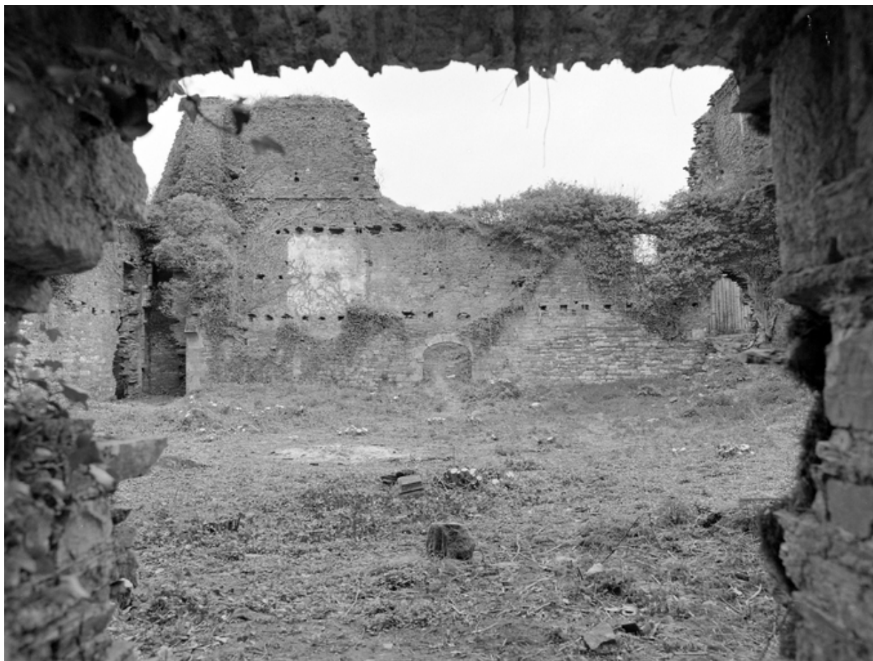
Cloître : vue prise vers le nord (état en 1977).
