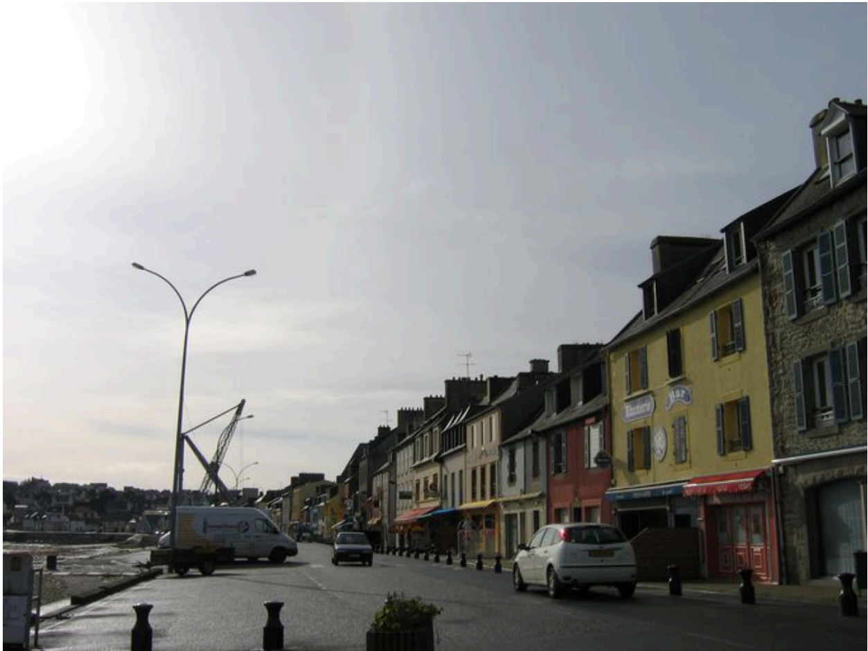
Vue générale du front portuaire Toudouze
