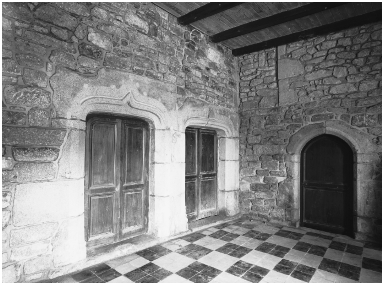
Salle à manger, murs nord et ouest : vue générale des portes
