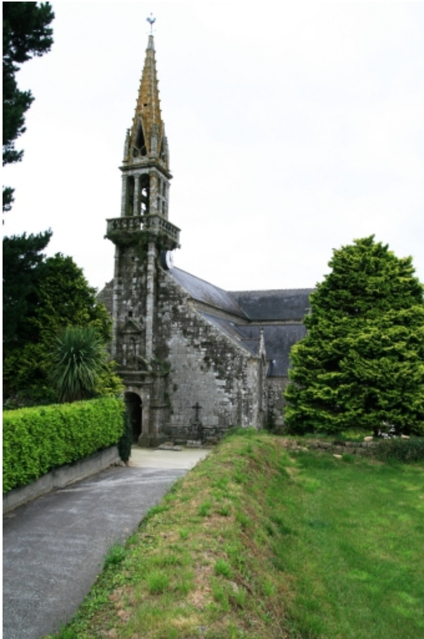
Quéménéven, église paroissiale Saint-Ouen : vue générale sud-ouest
