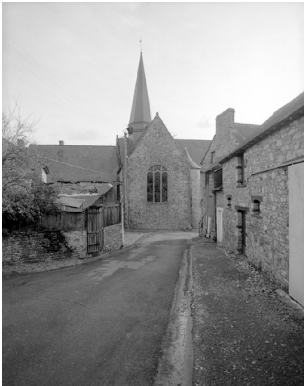
Elévation Nord, bras Nord du transept : vue générale
