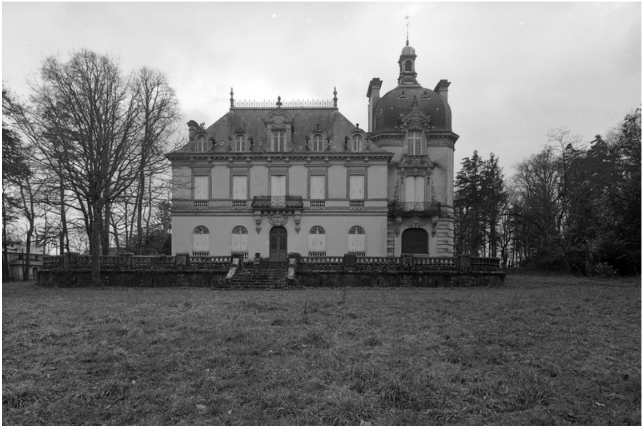
Façade nord, vue générale.
