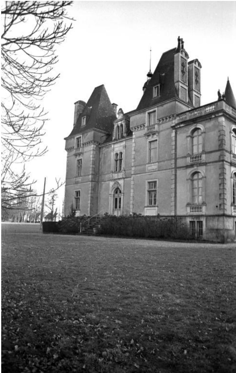
Façade nord (état en 1973)
