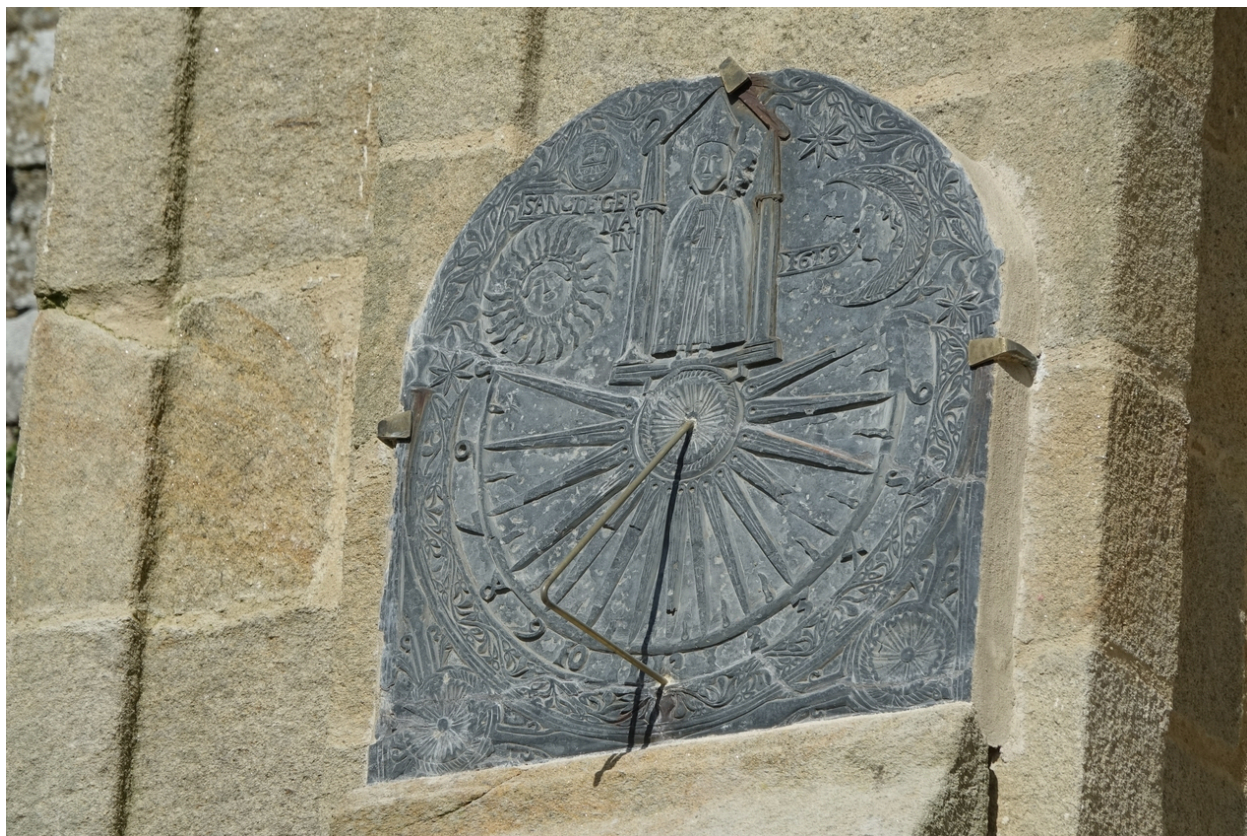
Tour-porche, détail du cadran solaire (2022)
