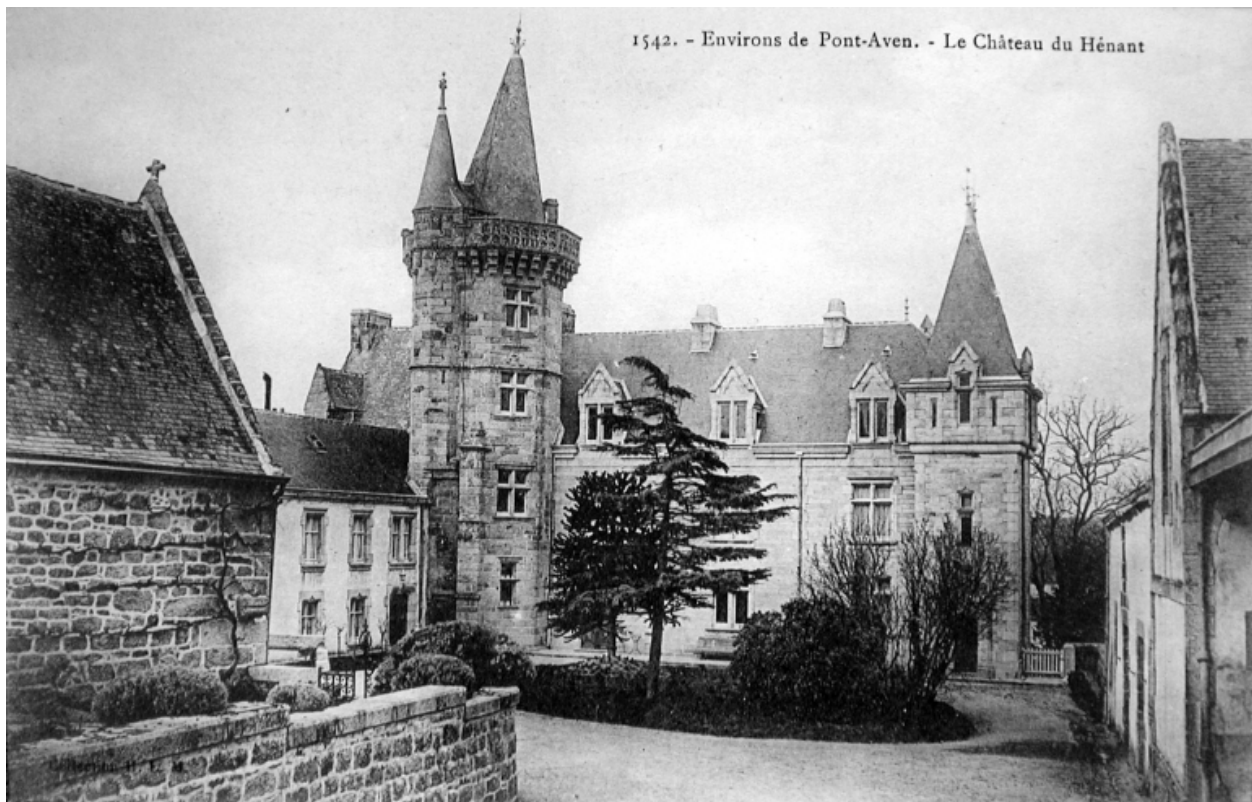
Vue générale depuis la cour centrale
