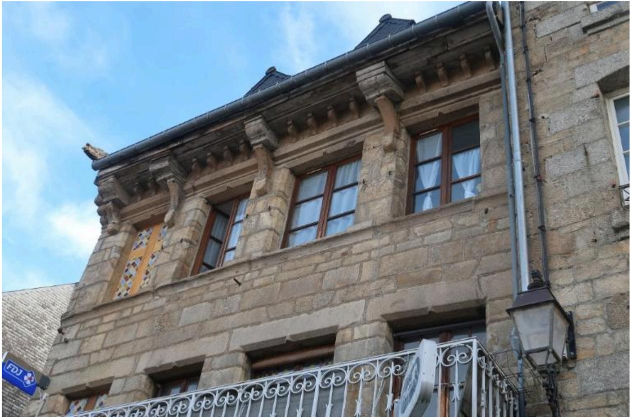
Des consoles en bois appuyées sur des corbelets en forme d'écus soutiennent les poutres de la toiture.
