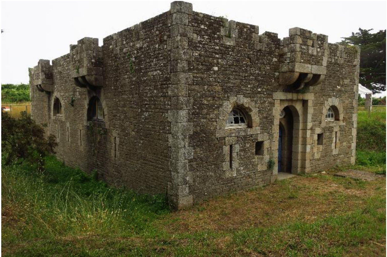
Groix, batterie du Gripp, corps de garde crénelé, angle sud-ouest.
