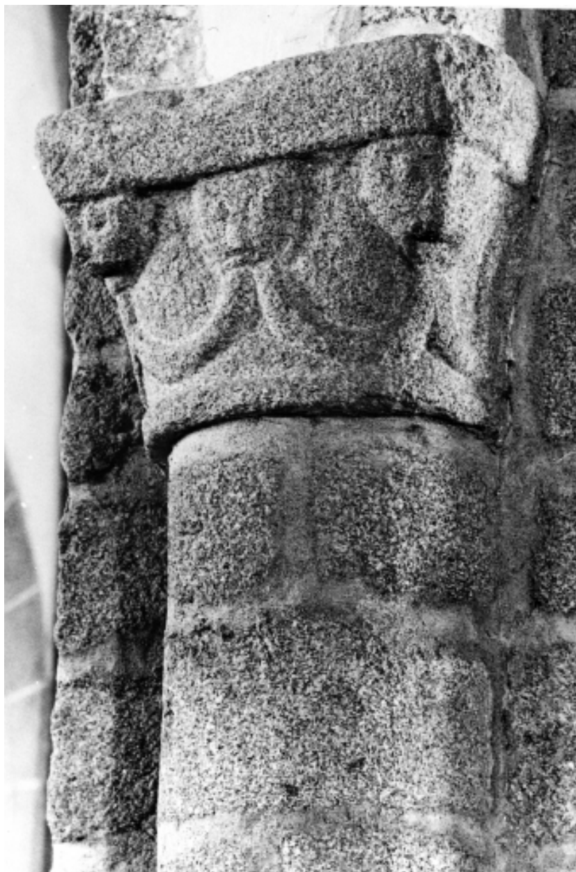
Intérieur : détail de la pile n°4, face ouest.
