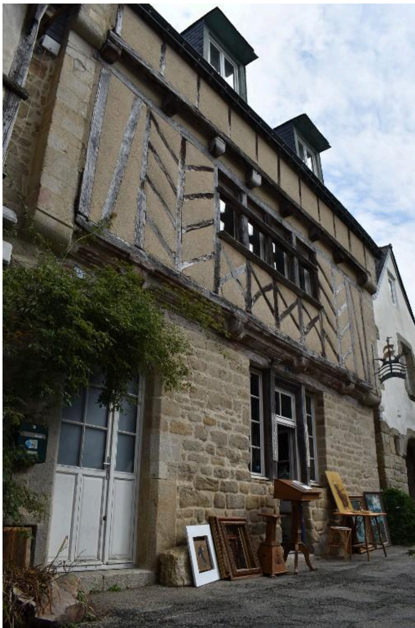
Façade en pan de bois avec encorbellement sur solives
