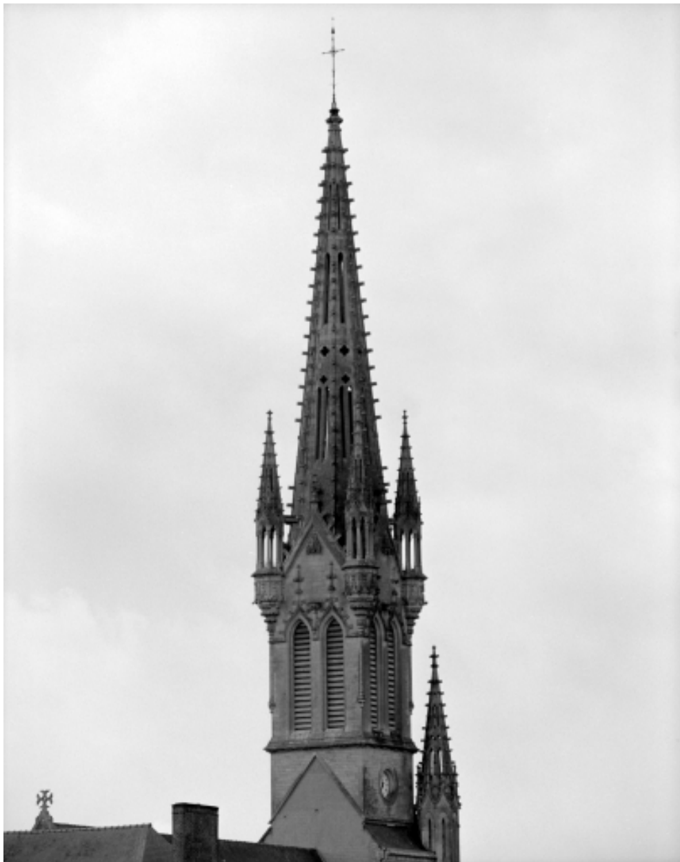
Clocher, partie supérieure : vue générale.
