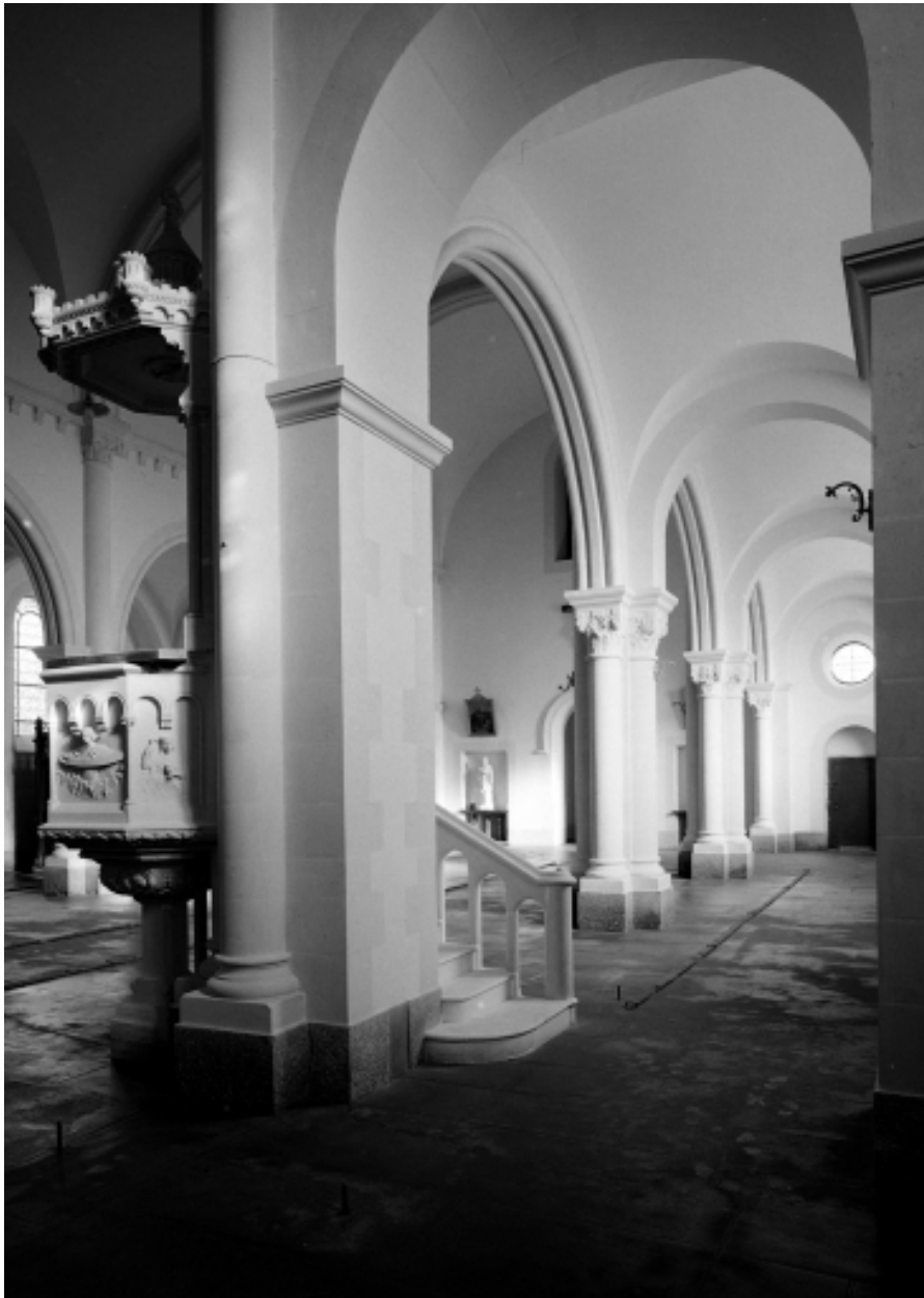
Intérieur, nef, bas-côté Nord : vue Nord-Est.
