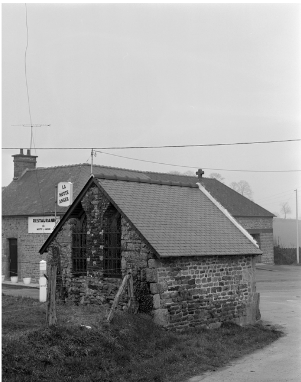
Elévation Ouest : vue générale
