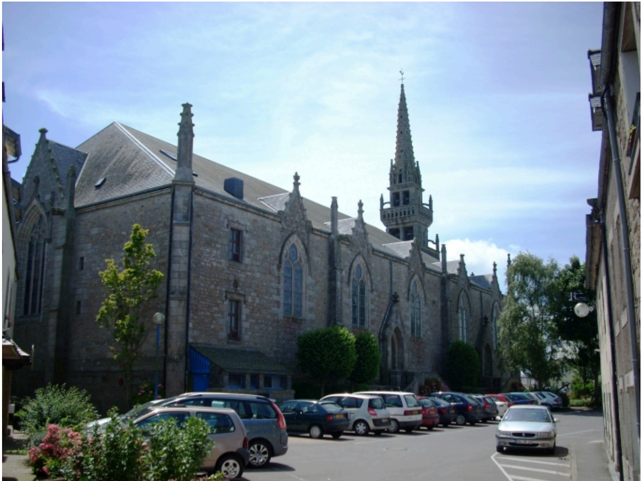
Cléder, église paroissiale Saint-Pierre : vue générale nord-est
