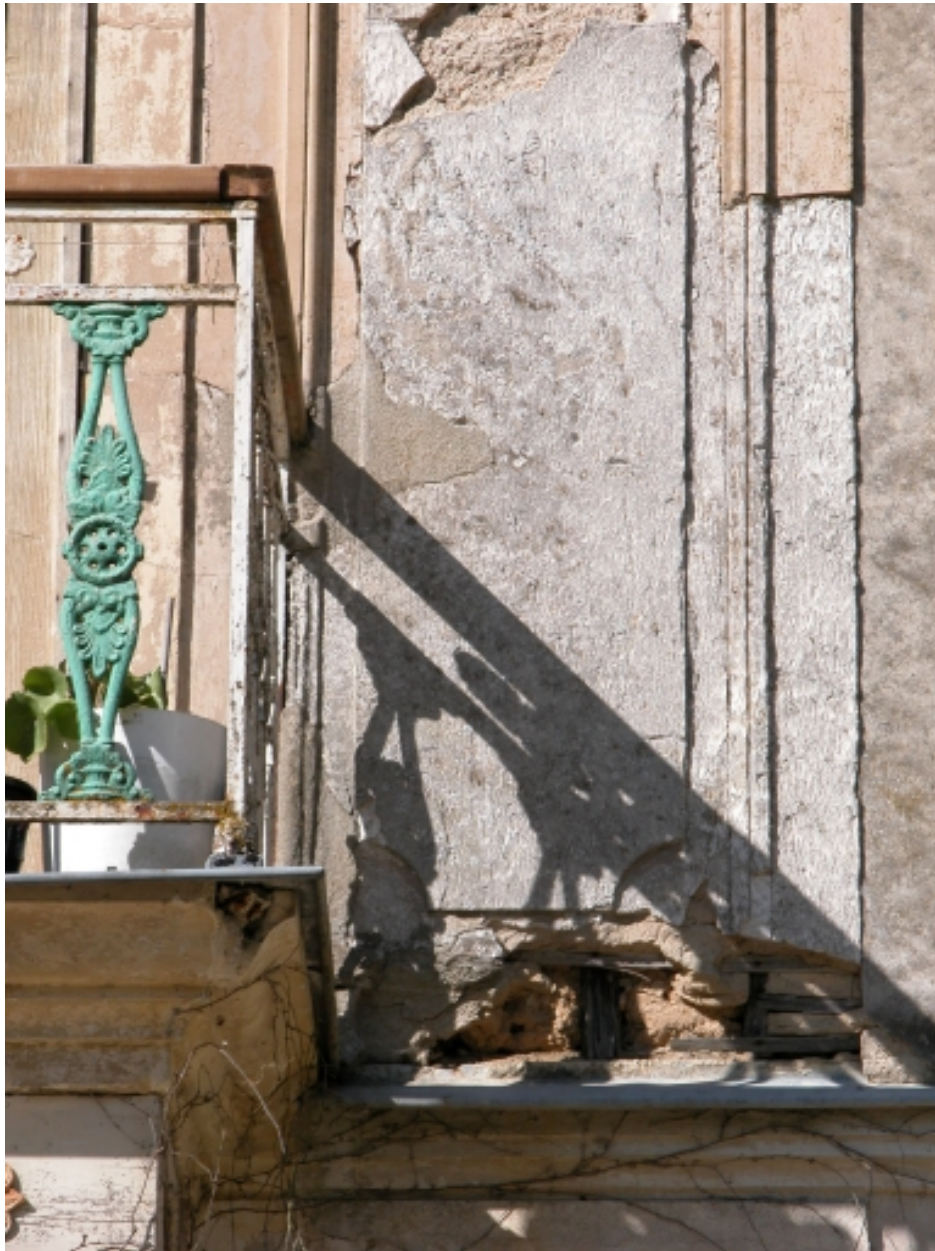
Détail sur l'enduit.
