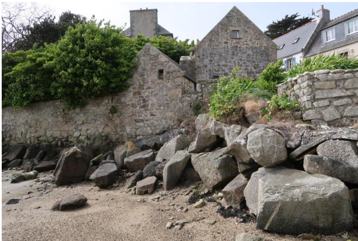
Pors an eog, murs de soutènement et enrochements
