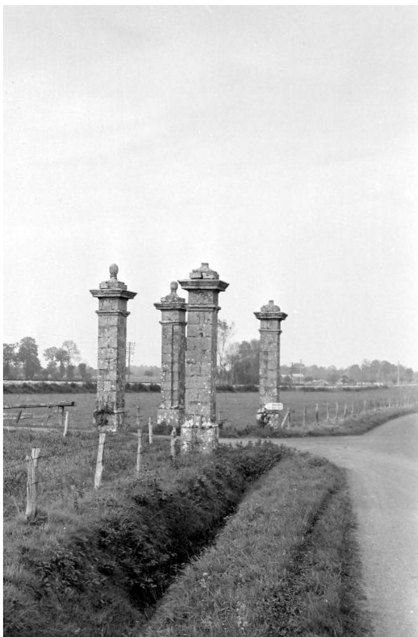
Les quatre piliers vus en sortant
