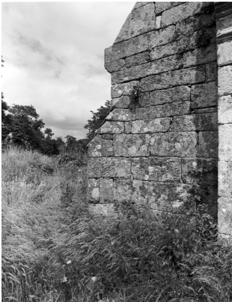
Façade ouest, détail : angle nord-ouest
