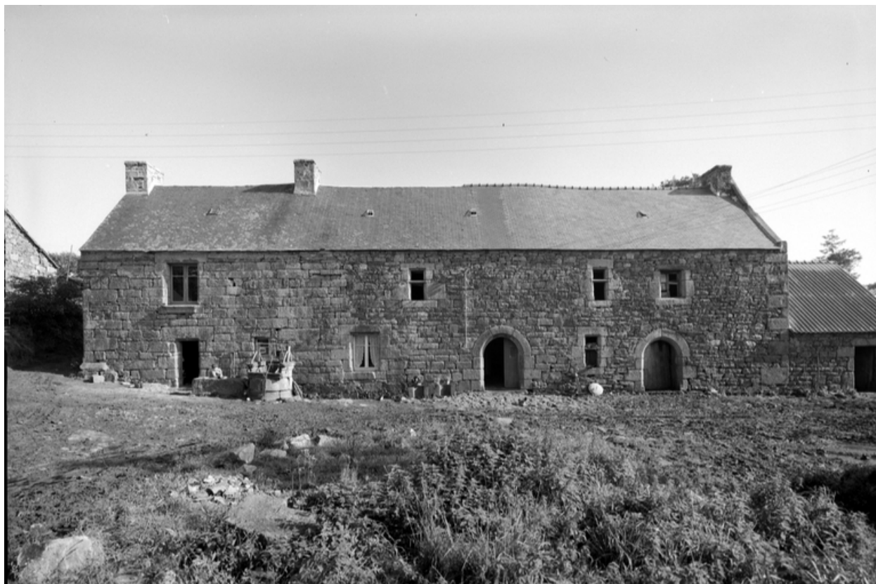
Vue de la face antérieure
