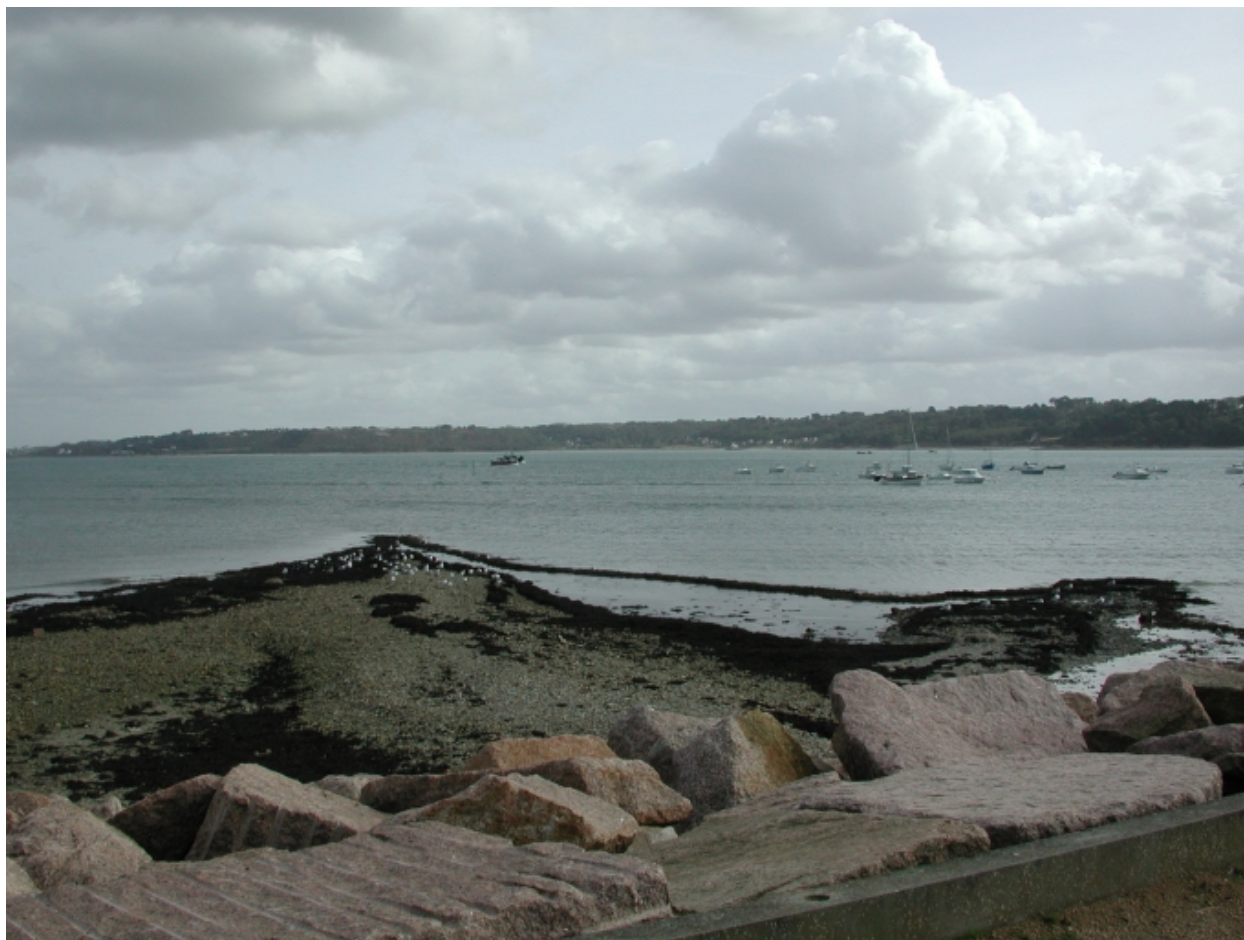
Enrochement du rivage et cordon de galets à l'est de la cale du Ch'raou
