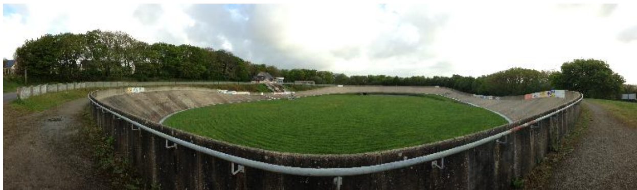
Vue panoramique prise depuis le virage sud
