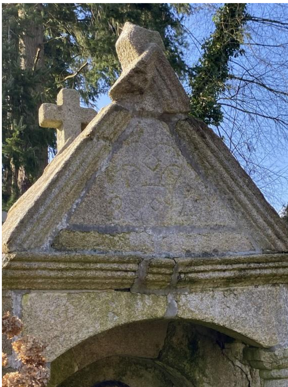
Toit à bâtière avec date, 1847, vue sud.
