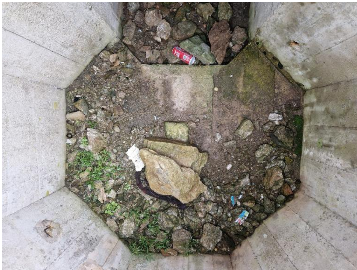
Vue intérieure : plan octogonal. En haut, escalier d'accès au poste d'observation et de tir
