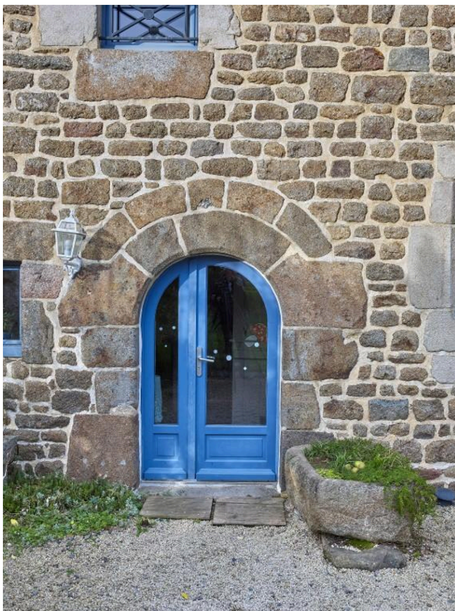
Logis principal. Façade sud. Détail de la porte à double cintre
