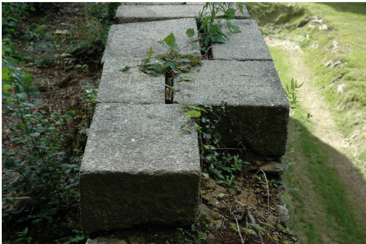
Vue de l'ouvrage à cornes de Quéliverzan : couronnement du parapet des créneaux de fusillade
