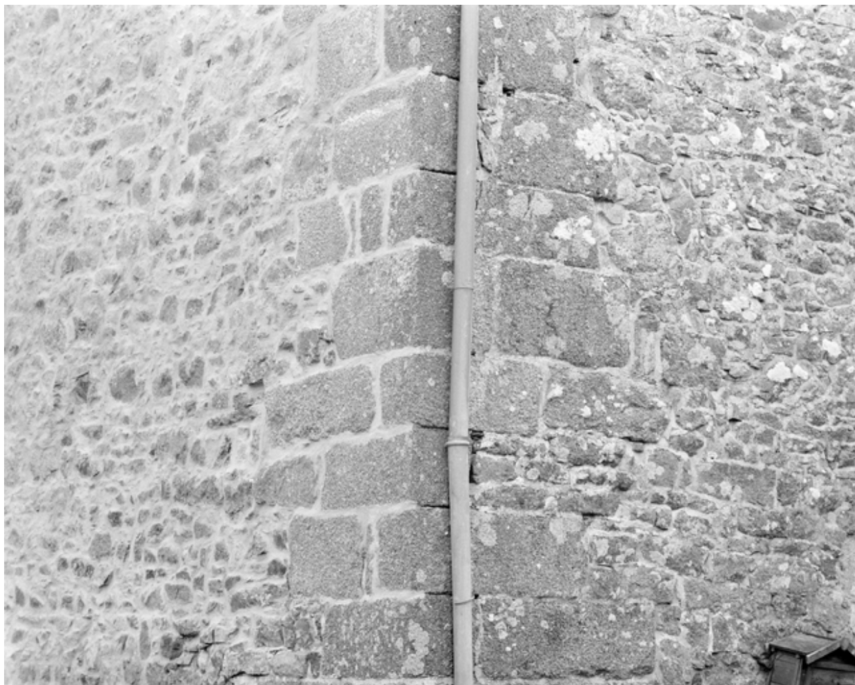
Logis : détail d'harpes de pierre à un angle de la façade.
