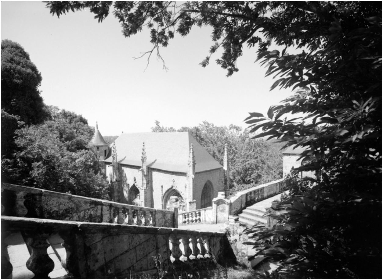
Vue générale de la chapelle et des escaliers prise du sud.
