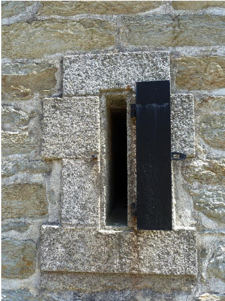
Le Palais, citadelle, magasin à poudre de l'Avancée, évent d'aération.
