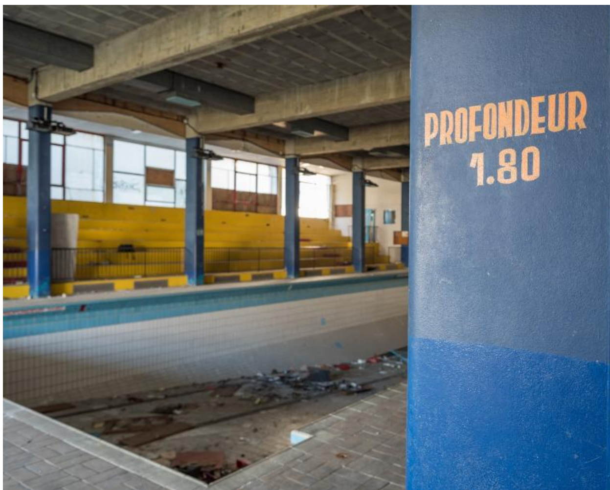
Vue en diagonale du grand bassin, prise face aux tribunes. Jean de Jaegher et François Rousseau, architectes, 1968.
