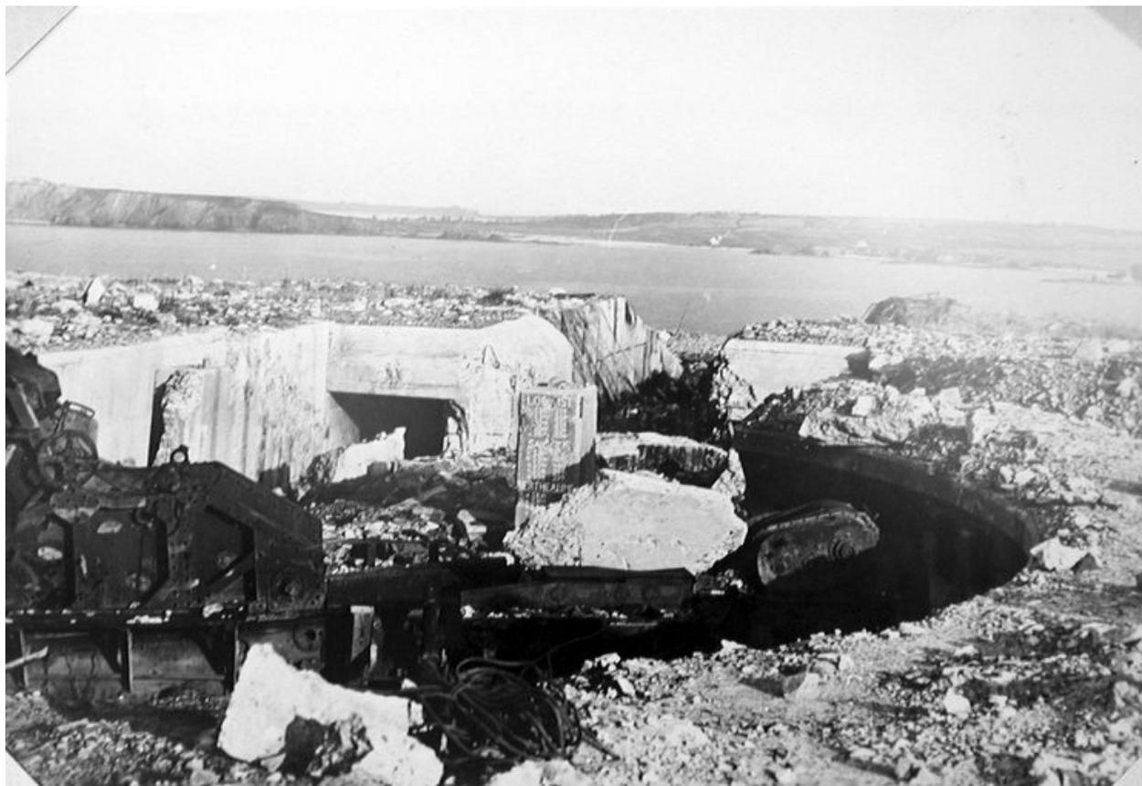
Vue de l'un des quatre canons Schneider de 22 cm K.552 modèle 1917 (f) montés en cuve, extrait du rapport Pinczon du Sel, photographie n° 124, vers 1946-1947
