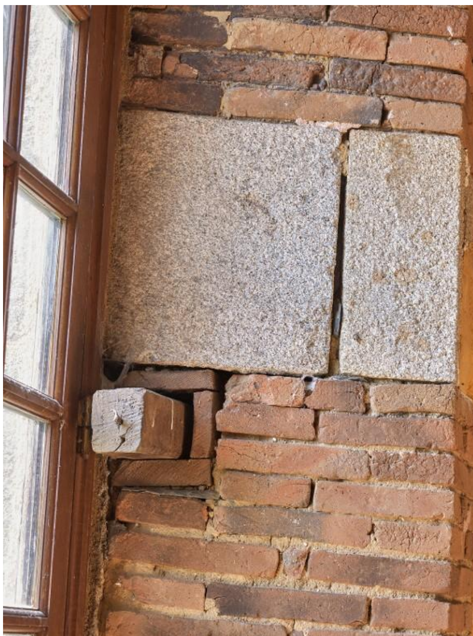
Barre de bois qui s'intègre dans le mur pour barricader la fenêtre à l'étage
