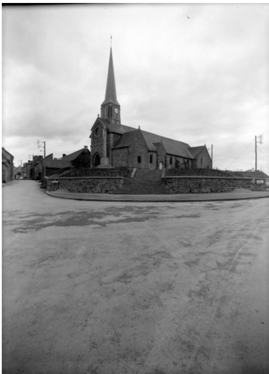
Elévation Sud-Ouest : vue générale
