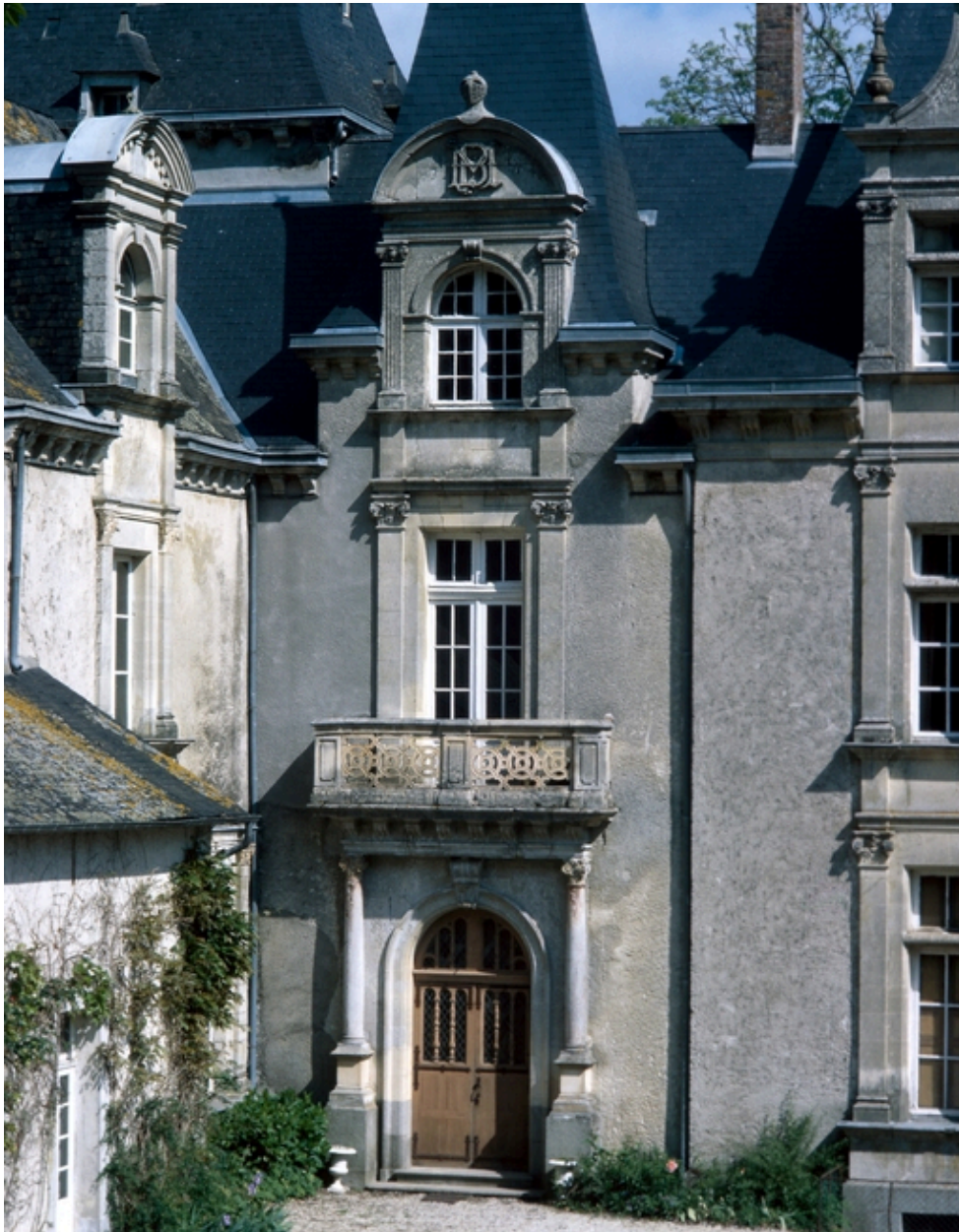
Vue générale de la façade d'angle avec entrée.
