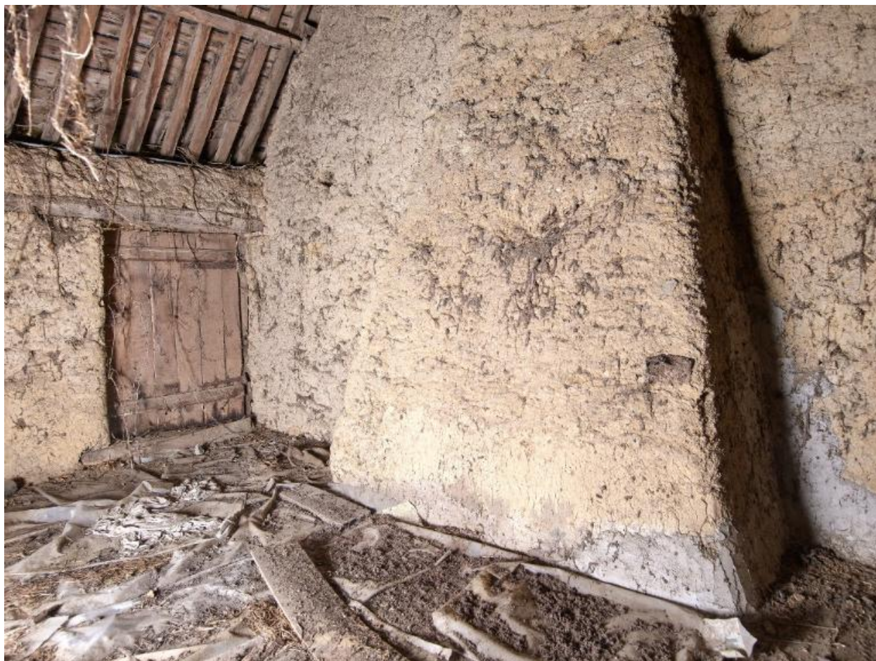
Conduit de la cheminée en terre
