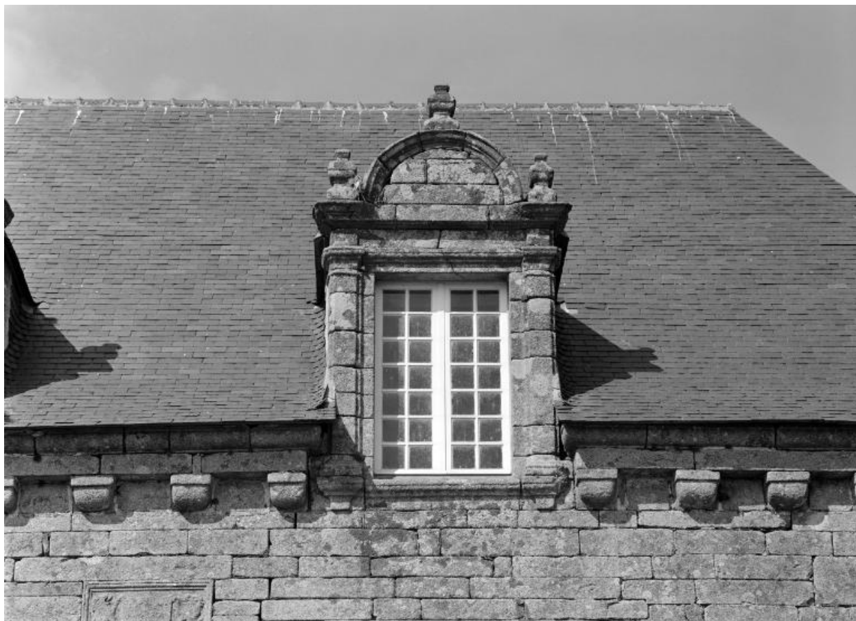
Lucarne et corniche sur la façade sud de la partie centrale
