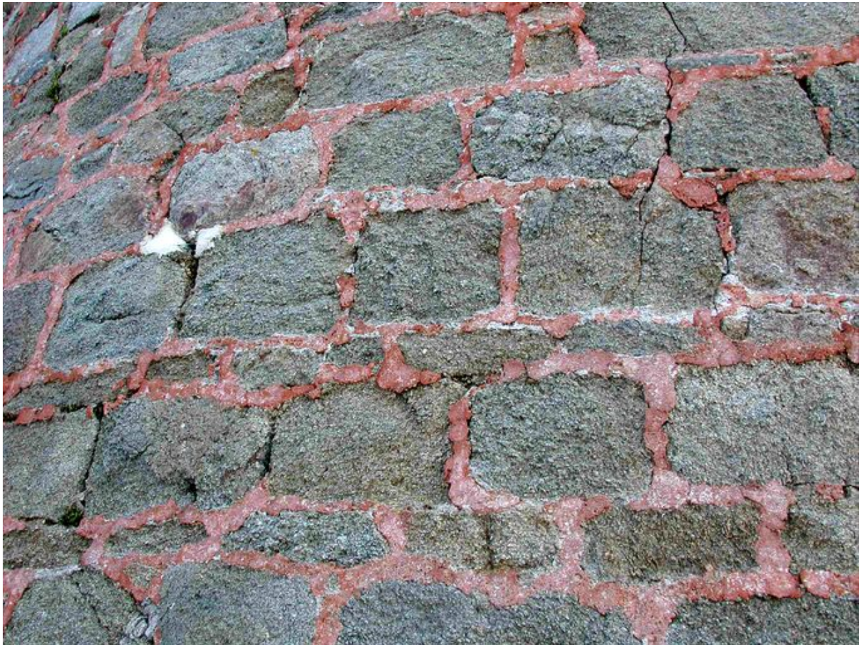
Perros-Guirec, fort de l'île aux Moines : détail de l'appareillage des pierres de la redoute de l'île aux Moines. La couleur rosée du joint vient de l'adjonction dans le mortier de poudre de brique
