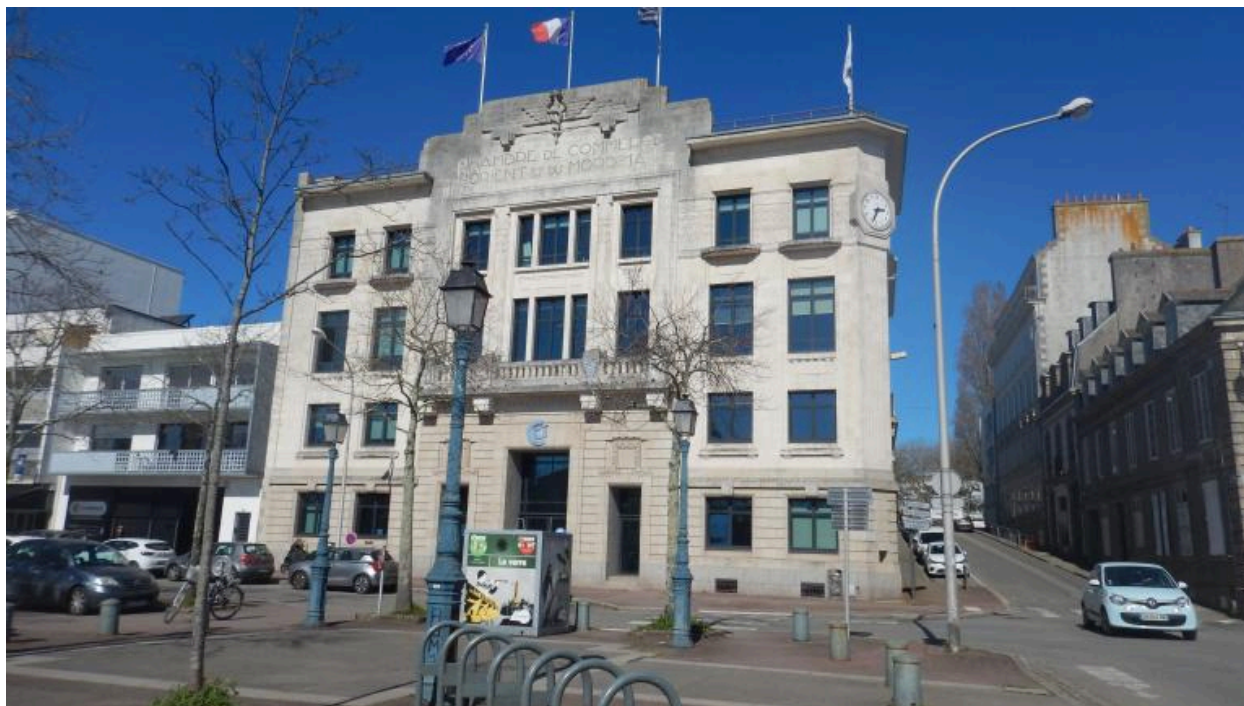
Chambre de commerce et d'Industrie du Morbihan, façade principale (1928)
