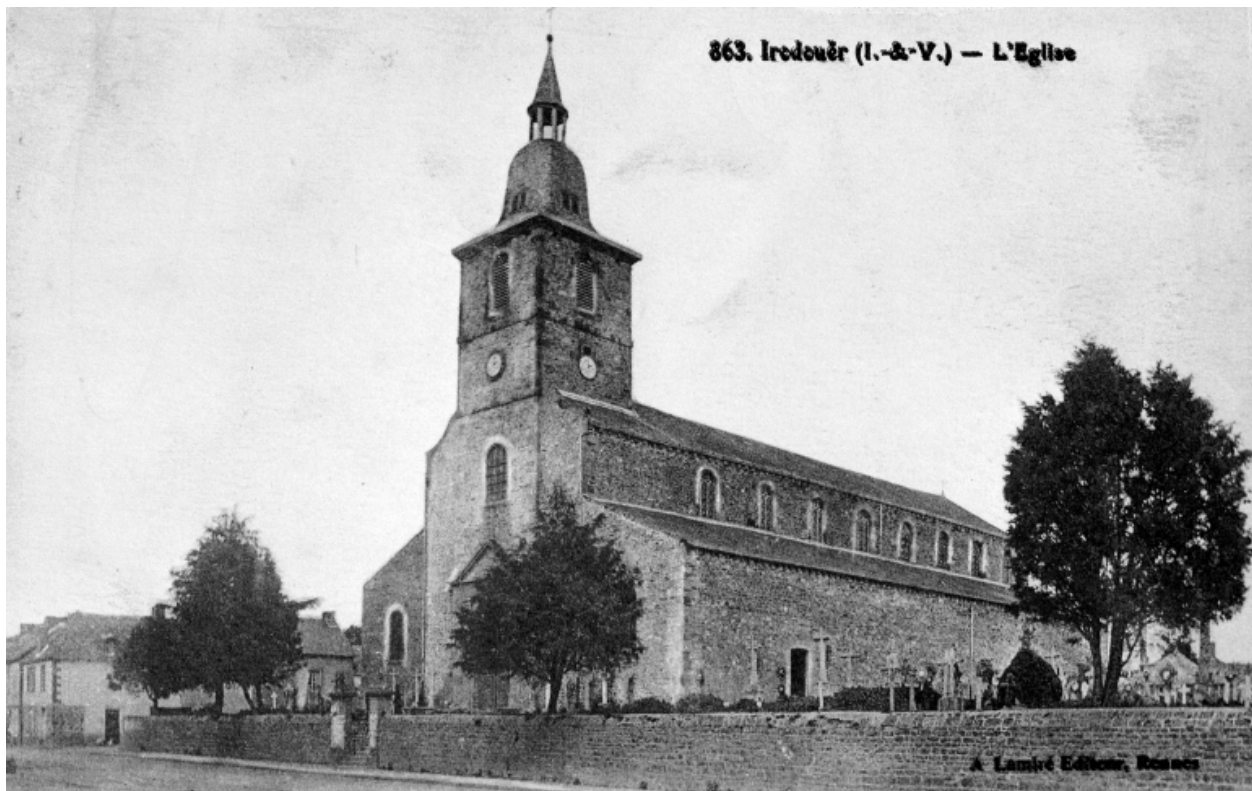
Carte postale ancienne. Elévation Sud-Ouest : vue générale.
