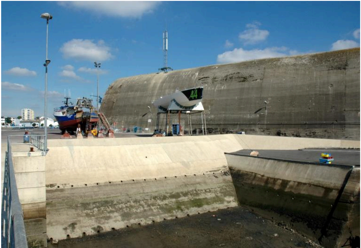
Vue générale depuis le sud-sud-ouest (2005). Au premier plan, le quai - à marée basse - servant à l'élévateur à bateaux
